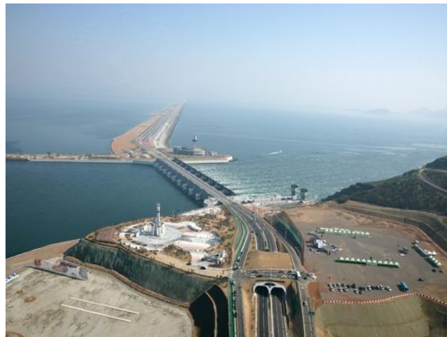
Saemangeum Seawall (33.9km)
